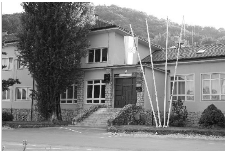
Upravna zgrada Grada Pregrade (foto: Vinko Krištić)
